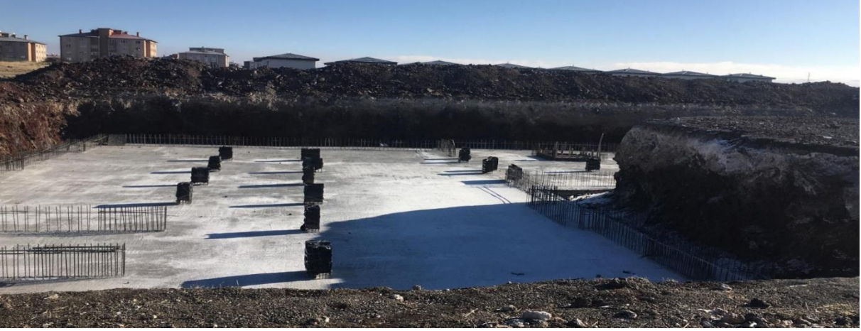
Kars Arpaçay YİBO 16 Derslik Okul İle 200 Kişilik Yurt Yapım İşi
